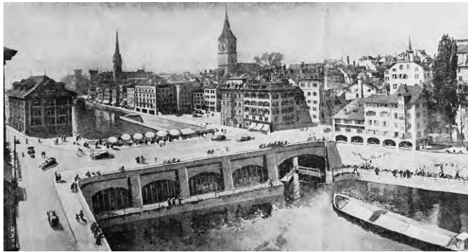
Ein bombensicheres Kraftwerk und eine Schiffsschleuse in der Rathausbrücke sollten den Zürichsee mit den Weltmeeren verbinden (Bild: «Die Tat», 20. Mai 1938).
