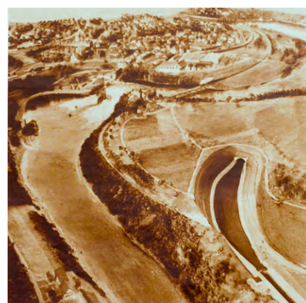
Mit Schleuse und Tunnel sollte der Rheinfall umschifft werden. Modell, ausgestellt an der Landi 1939 (Bild: Schweizer Illustrierte Zeitung, Nr. 39, 1939).
