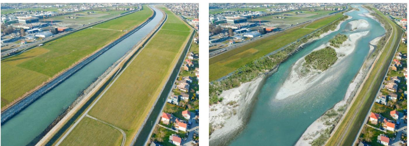
Abb. 3: Alpenrhein im Abschnitt Widnau und Lustenau heute (links) und visualisiert für Zustand nach Umsetzung Projekt (rechts). Die Gerinnebreite im Abschnitt Viscose beträgt dann 300 m. Im verbleibenden linksseitigen Vorlandstreifen werden die Grundwasserfassungen neu angeordnet. Visualisierung Büro Hydra GmbH.
