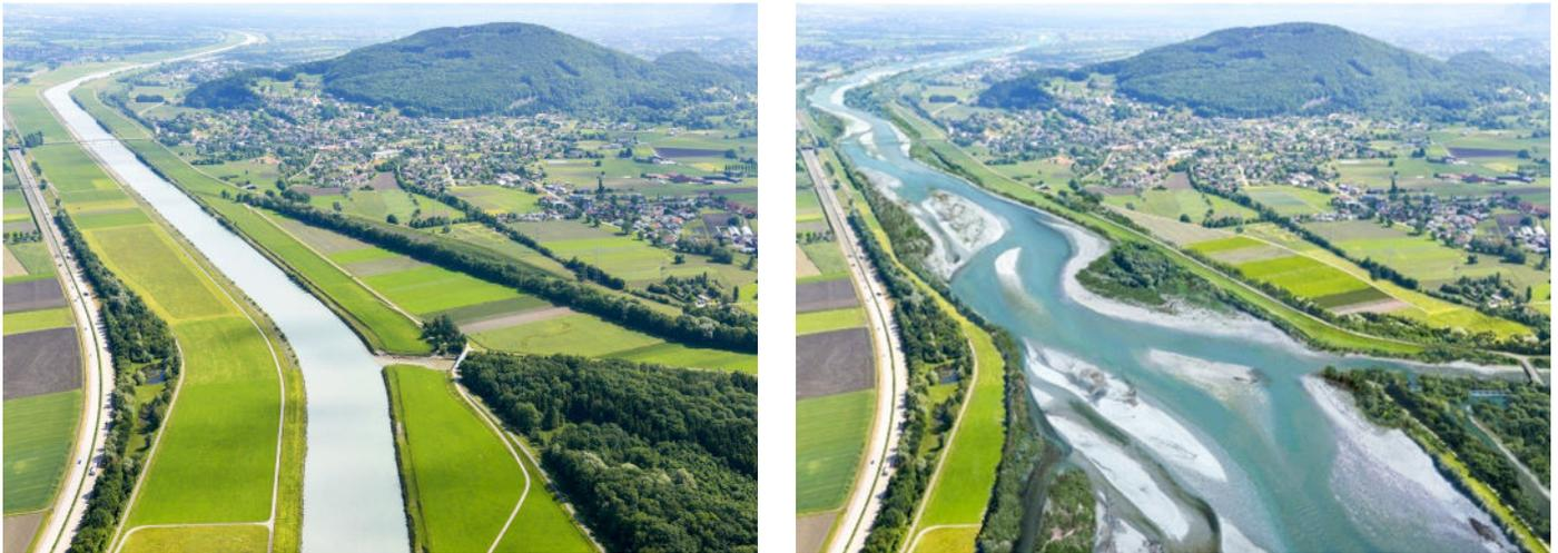
Abb. 2: Alpenrhein im Abschnitt Oberriet-Koblach heute (links) und visualisiert für Zustand nach Umsetzung Projekt (rechts). Die Gerinnebreite in diesem Abschnitt beträgt neu bis zu 380 m. Visualisierung Büro Hydra GmbH.
