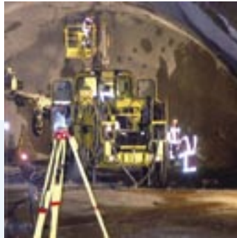
Bau- und Ingenieurvermessung Mensurations techniques et industrielles
